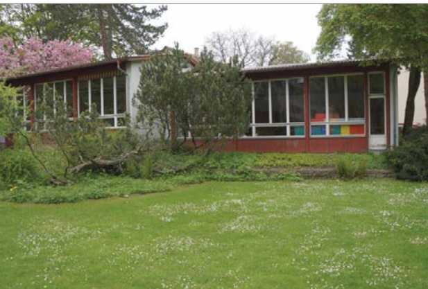
Das eingeschossige Kindergartengebäude zeichnet sich durch grossflächige Fenster aus. Das Gebäude stammt aus den 1950er-Jahren und ist sanierungsbedürftig. Das Bild zeigt die Südfront des Gebäudes.
